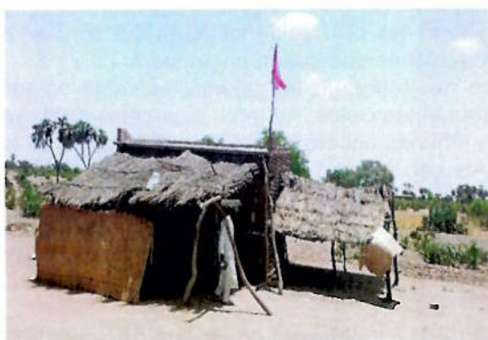
Vue extérieur du CS de Koblagué, 27/04/2021
